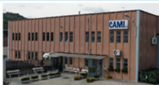
Colonnella - TE CAMI S.r.l. Sede Produttiva
